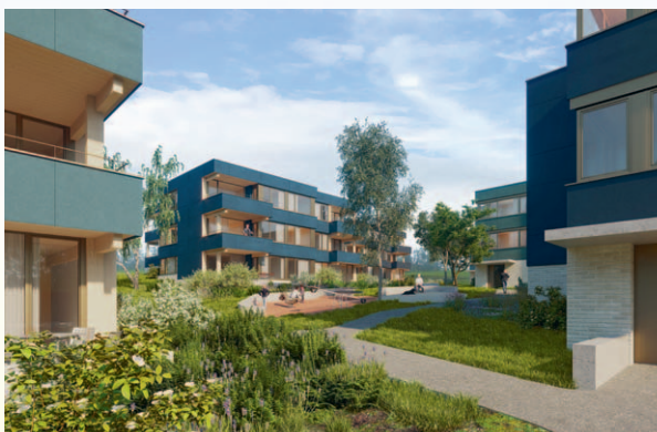
Le projet vainqueur du concours d'architecture à Birmensdorf ZH est réalisé sous la forme d'une construction en bois avec une façade ventilée. Le développement de projet se fonde sur les normes SNBS 2.0.
