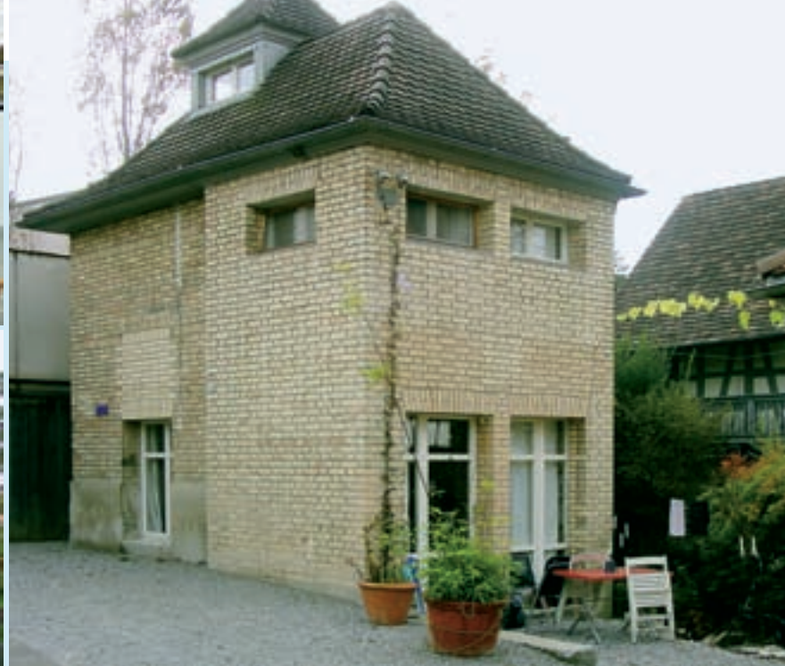
Oben: Shed-Halle Unten: Fassade Rechts: Trafohaus (Einzimmerwohnung)
